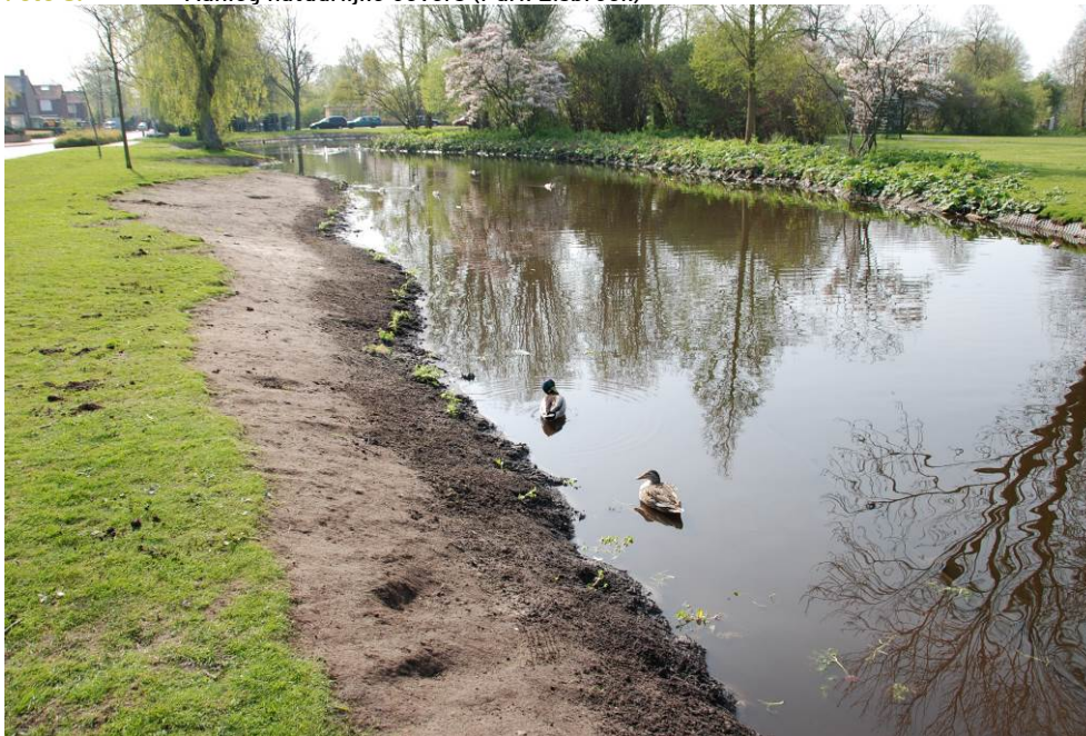
Foto 6. Aanleg natuurlijke oevers (Park Elsbroek)
