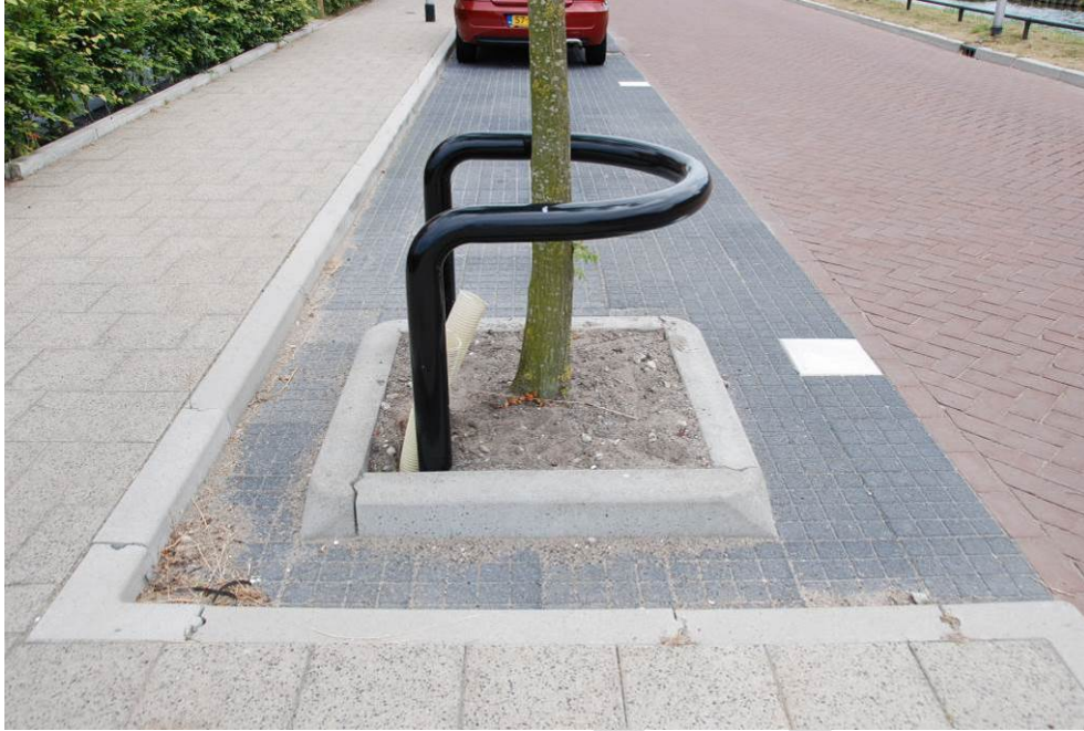
Foto 8. Een verhoogde band voorkomt strooizoutinspoeling (Schellinkhout). N.b.: een grotere boomspegel is beter; zie maatvoeringseisen in bijlagen.
