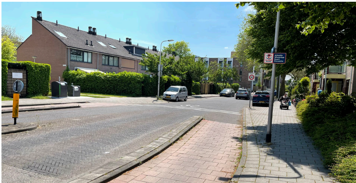
Figuur 5: Entree van 30 km/h-zone zonder inritconstructie
